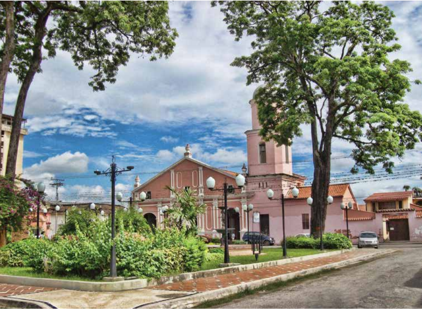
Iglesia Santo Domingo, San Carlos, estado Cojedes. Lugar donde fueron velados en capilla ardiente los restos del prócer Fernando Figueredo. Fotografía de Samuel Sánchez Terán.
